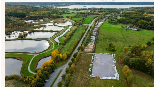
Magle våtmark till vänster och VA-projektet längs Södra kringelvägen till höger. Foto Thomas Johnsson
